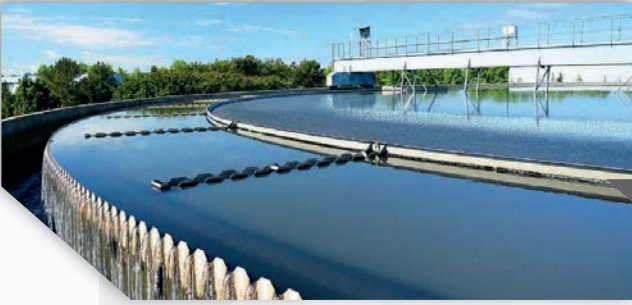
Su Arıtma Tesisi Water Treatment
